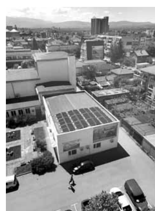
Фотоволтаична инсталация 15 kW – ДЦРДУ
