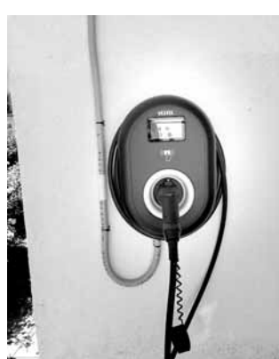
Доставка и монтаж на Зарядна станция 22 kW
